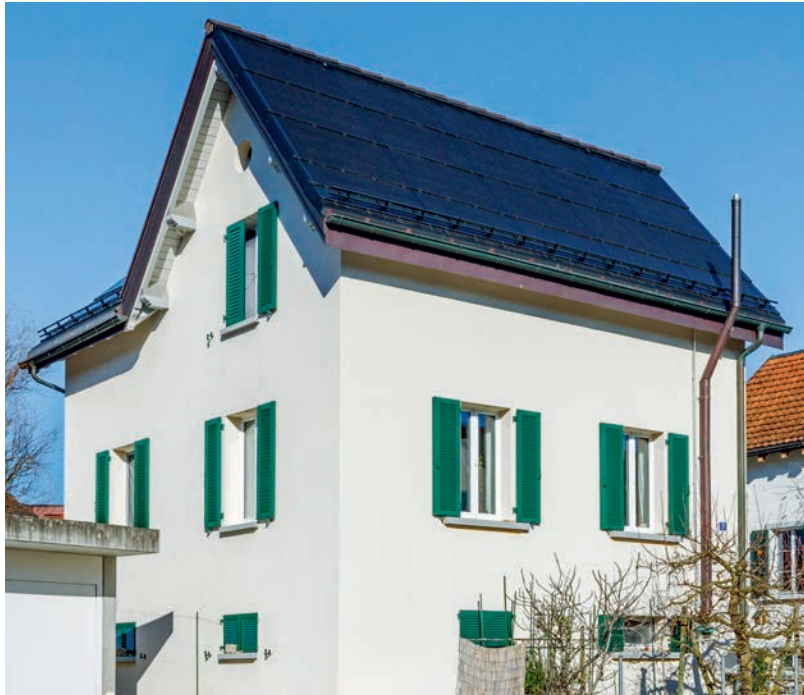
PV-Anlage mit Leistung von 7.9 kWp
