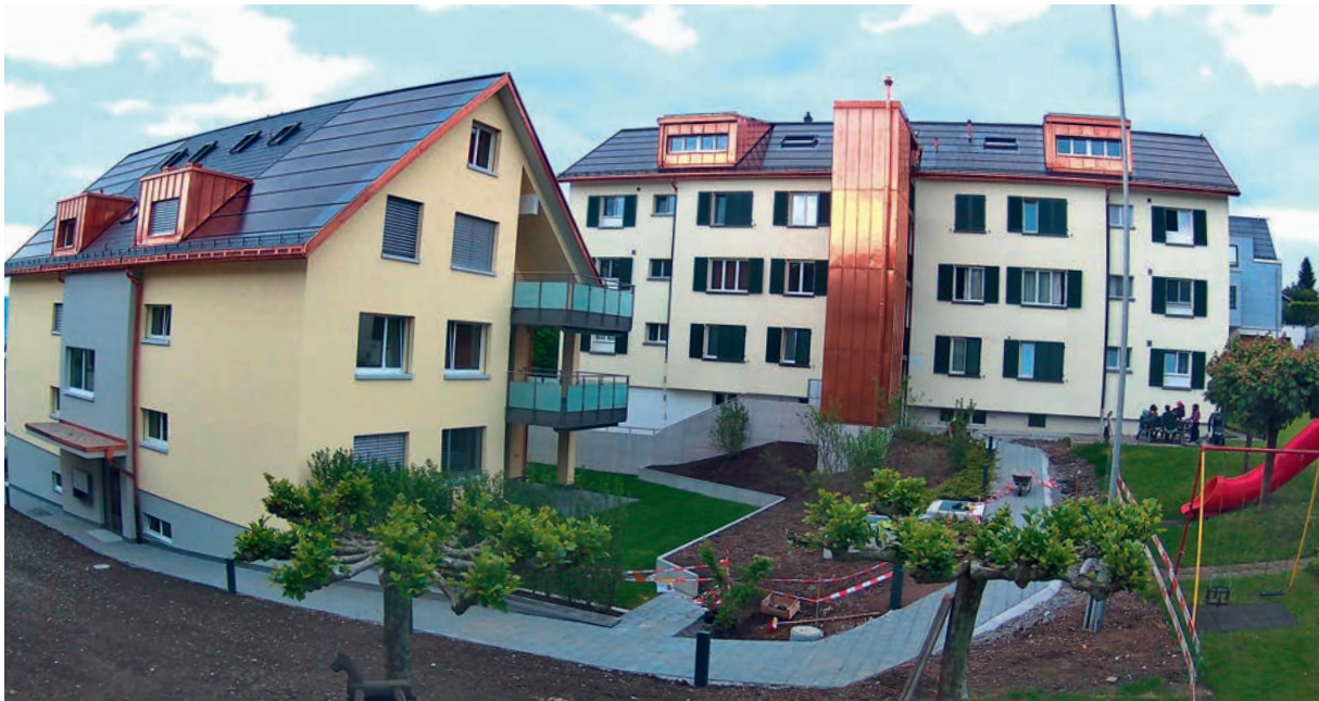
Abschluss der Arbeiten im Mai 2025
