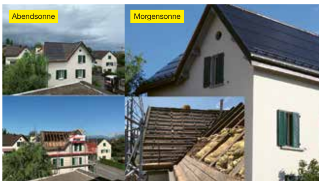
Anlage an der Nordstrasse 3. Das sehr alte ungedämmte Dach musste zuerst neu isoliert werden, damit nicht unnötig Energie durch den Dachstock entweicht. So machte hier eine Indach-Anlage Sinn. Dabei wurden die Module als Ziegelerersatz direkt in die Dachkonstruktion montiert.
