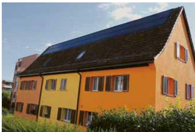
Anlage Zugerstrasse 92–96. Hier war der Dachstock bereits gedämmt und in gutem Zustand; es konnte eine Aufdach-Anlage montiert werden.
