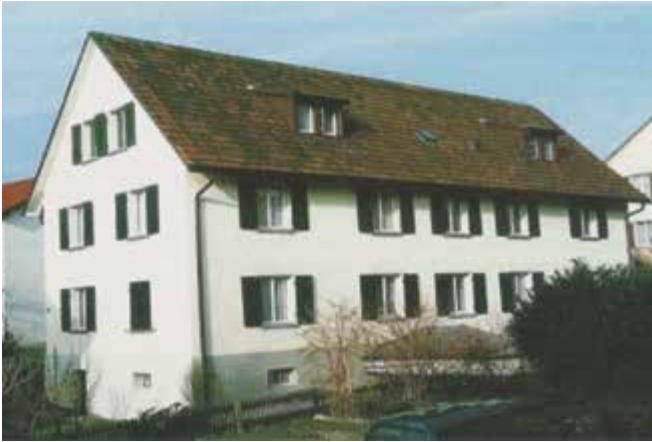
Erwerb der Liegenschaft Weststrasse 4. Die Liegenschaft Weststrasse 4 liegt unmittelbar neben Liegenschaften, welche bereits der Mieter-Baugenossenschaft gehören. Es befinden sich 5 Wohnungen in diesem Haus. Der bauliche Zustand kann als gut beurteilt werden. Der Kaufpreis betrug Fr. 1'000'000.–.
